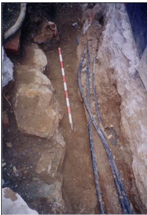
F5: Vista en planta del mur (UE-05)
