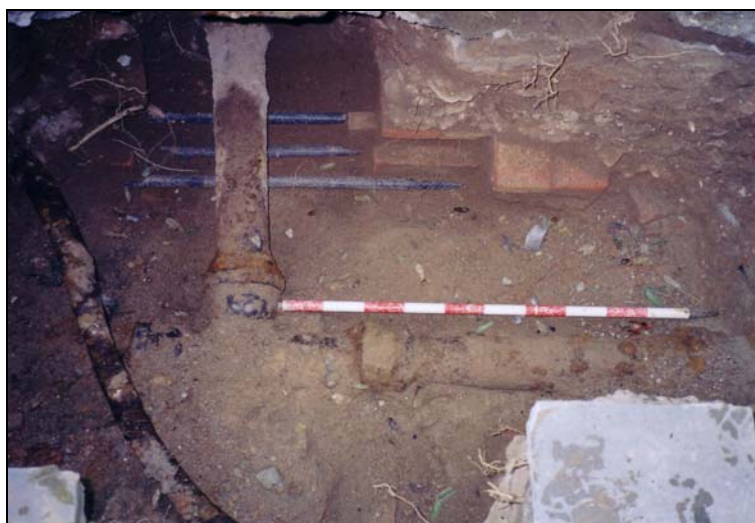
F2: Vista del sondeig 1, on s'observen la tuberia de l'aigua, els cables elèctrics, el cable d'oli antic per la llum; i les rajoles que recobreixen aquestes canalitzacions.
