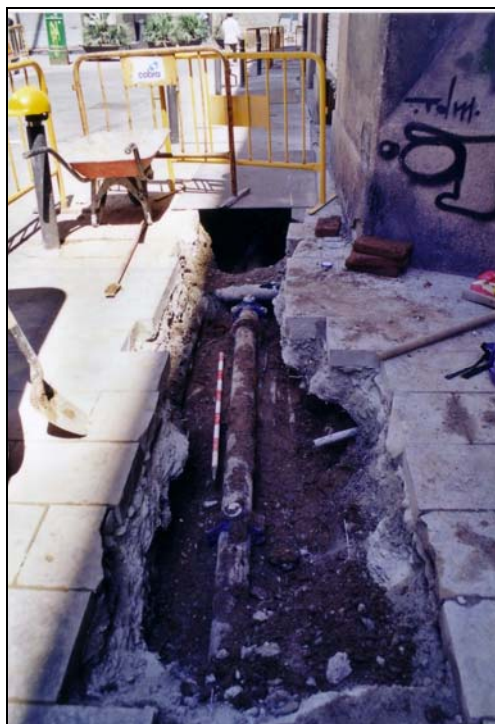
F9: Vista general del tram 4.
