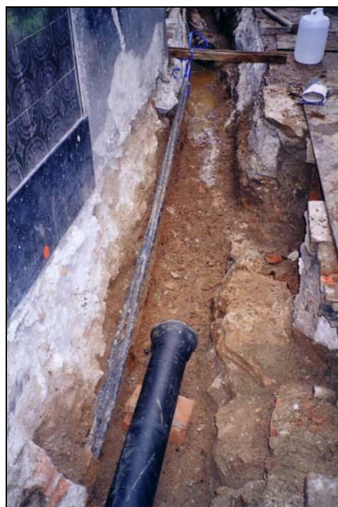
F6: Vista general del tram 2
