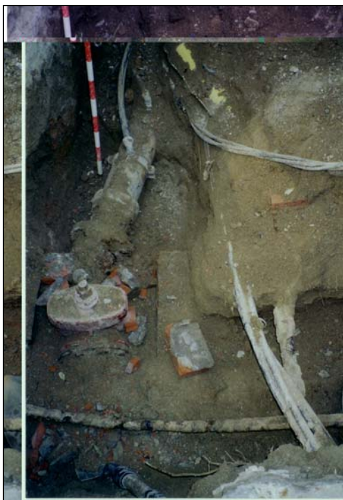
F3: Vista de les tuberies del sondeig 1.
