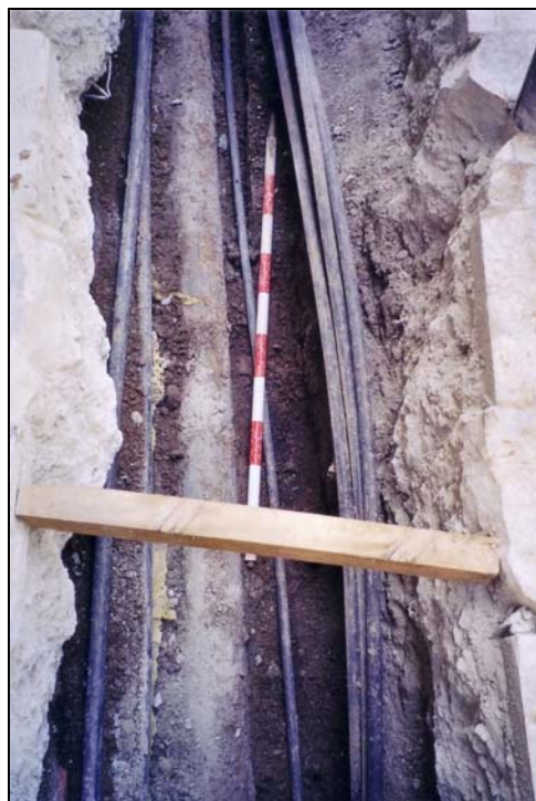
F8: Vista de l'entremat de tubs i cables en el tram 3.
