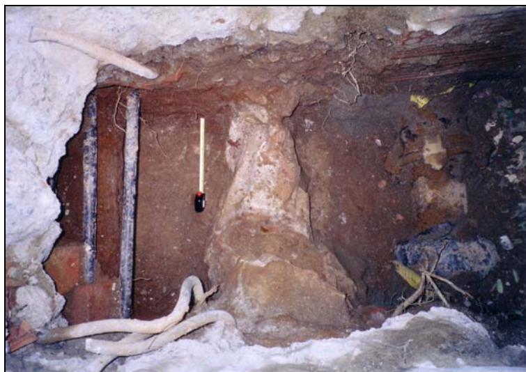
F1: Vista del sondeig 3, la UE-05 i els cables elèctrics.
